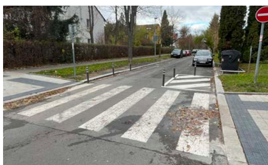
Opatření u přechodu pro chodce, kde parkovala vozidla oboustranně tak, že nebyly zajištěny potřebné rozhledy pro přecházení; vlevo původní, vpravo nová situace (ZŠ Solidarita, Praha 10)
