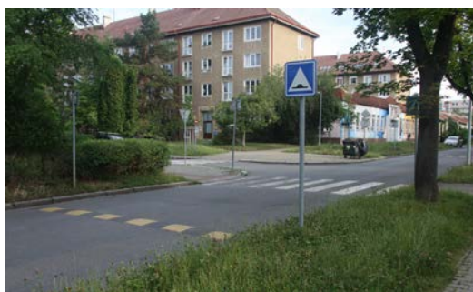
Odstranění keřů, které překážely v rozhledech a nahrazení zpomalovacího prahu, jehož parametry nebyly dostatečné pro zklidnění provozu; vlevo původní, vpravo nová situace (ZŠ Solidarita, Praha 10)
