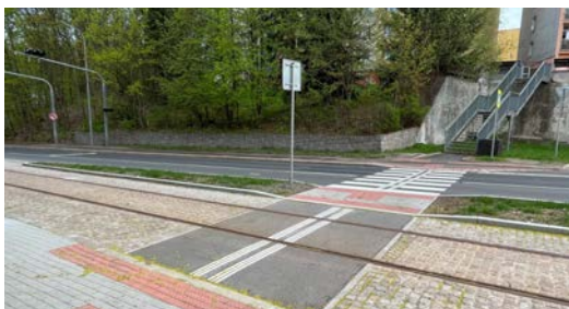
Vlevo: stavebně řešené místo pro přecházení přes tramvajovou trať (Jablonec n. Nisou)
