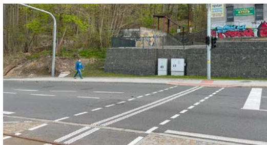
Vlevo: stavebně řešené místo pro přecházení přes tramvajovou trať (Jablonec n. Nisou)
