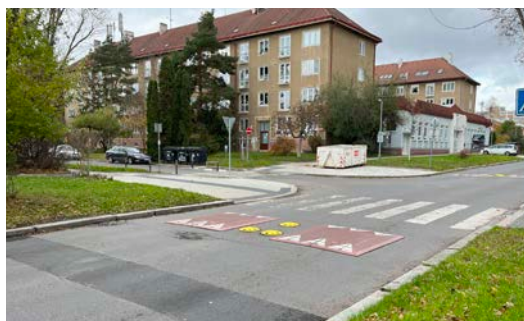
Odstranění keřů, které překážely v rozhledech a nahrazení zpomalovacího prahu, jehož parametry nebyly dostatečné pro zklidnění provozu; vlevo původní, vpravo nová situace (ZŠ Solidarita, Praha 10)
