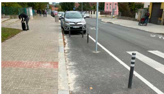
Odstranění zábradlí v délce 85 m a umístění nových přechodů a míst pro přecházení; vlevo původní, vpravo nová situace (ZŠ M. Alše, Praha-Suchbøl)
