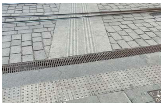
Typické bezbariérové řešení s prvky z betonových dílců (vlevo: Praha-Kunratice) a atypické řešení v památkových zónách (vpravo: Václavské náměstí, Praha 1)
