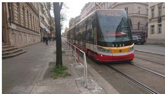
Zábradlí před školou v Ječné ulici dává vzhledem k velkému provozu smysl, bylo však umístěno příliš blízko vozovce a tramvajové trati, proto bylo navrženo jeho odsunutí; vlevo původní, vpravo nová situace (Praha 2)
