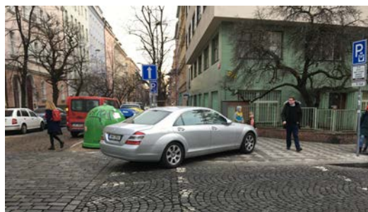
Místo pro přecházení v rámci zóny 30 na zvýšeném integrovaném prahu, avšak bez ochrany přidruženého prostoru proti najíždění a zastavování vozidel (Lauderovy školy, Praha 2)
