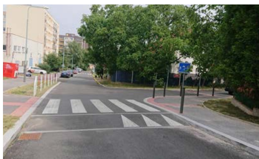
Přechod pro chodce na zvýšeném prahu
