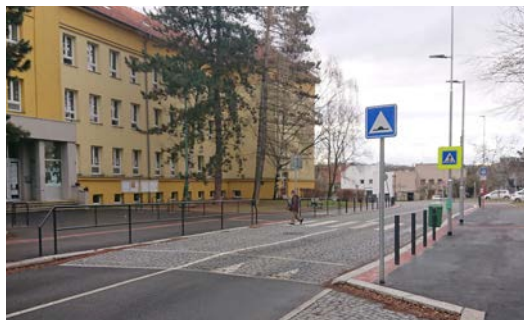
Zvýšená plocha komunikace před vstupem do školy
