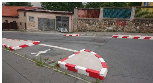
Vlevo: neznačené místo pro přecházení v úrovni vozovky jako dodatečné řešení bez povolení stavby, bezbariérové stavební úpravy pouze v rámci současných poloh obrubníků (ZŠ M. Alše, Praha-Suchbátov)
