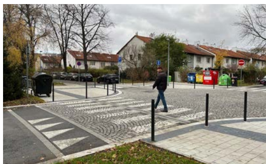
Rekonstrukce křižovatky s rampami zvýšené plochy a přechody na všech ramenech, nároží jsou chráněná sloupky; vlevo původní, vpravo nová situace (ZŠ Solidarita, Praha 10)
