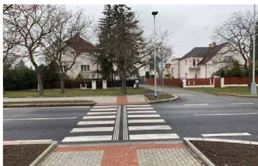
Typické bezbariérové řešení s prvky z betonových dílců (vlevo: Praha-Kunratice) a atypické řešení v památkových zónách (vpravo: Václavské náměstí, Praha 1)
