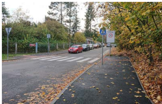
Nový chodník a přechod pro chodce na vjezdu do zóny 30, kde v původním stavu chyběl přístup od zastávky veřejné dopravy do sídliště; vlevo původní, vpravo nová situace (ZŠ Ružinovská, Praha 4)
