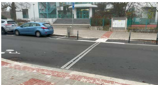
Vlevo: neznačené místo pro přecházení v úrovni vozovky jako dodatečné řešení bez povolení stavby, bezbariérové stavební úpravy pouze v rámci současných poloh obrubníků (ZŠ M. Alše, Praha-Suchbátov)
