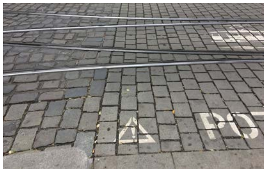
Úprava povrchu tramvajové tratě v místě pro přecházení s velkou dlažbou, s pochozím pásem, s řezanou horní hranou (vlevo: Karlovo náměstí, Praha 2, vpravo: muzejní oáza u Národního muzea, Praha 1)
