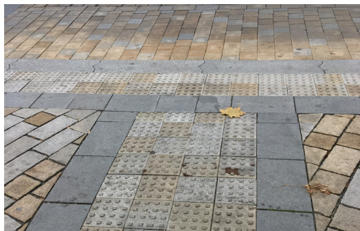
Úprava povrchu tramvajové tratě v místě pro přecházení s velkou dlažbou, s pochozím pásem, s řezanou horní hranou (vlevo: Karlovo náměstí, Praha 2, vpravo: muzejní oáza u Národního muzea, Praha 1)
